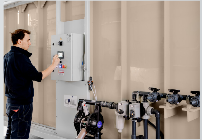
Quadro di comando, pompa e valvole di cambio colore Control panel, pump and colour change valves
